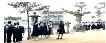
【改修中の宮島の鳥居と生徒】
