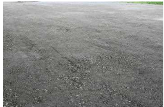
【きれいに整地された駐車場】
