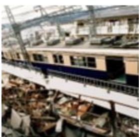
高架とともに崩れ落ちた阪神電車Ⅱ1995年1月18日、神戸市灘区大石東町
